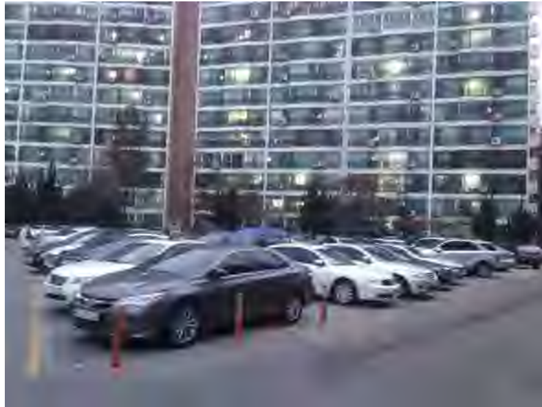
그림 71 은마아파트의 열악한 주차장 상황 1(2017.12.06. 황진태 촬영)
