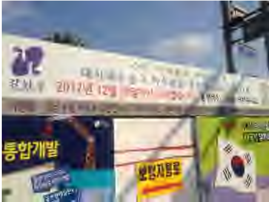
그림 8 대치배수분구 하수관로 공사현장(황진태 촬영 2017.11.4.)
