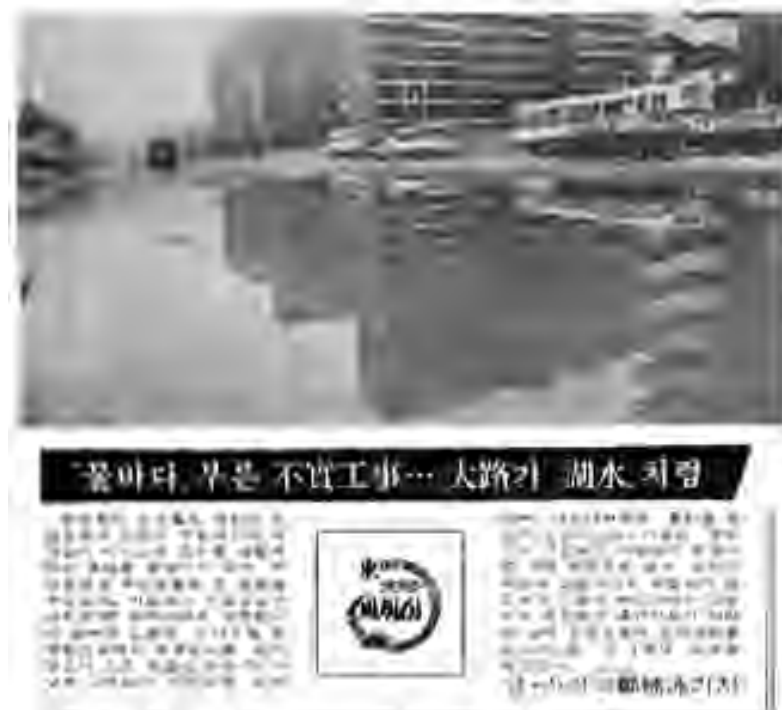
그림 5 은마아파트 앞 포장도로 부실공사로 인해 물난리가 발생했다는 보도기사(물바다 부른 부실공사...대로가 호수처럼, 경향신문 1980.09.17.)
