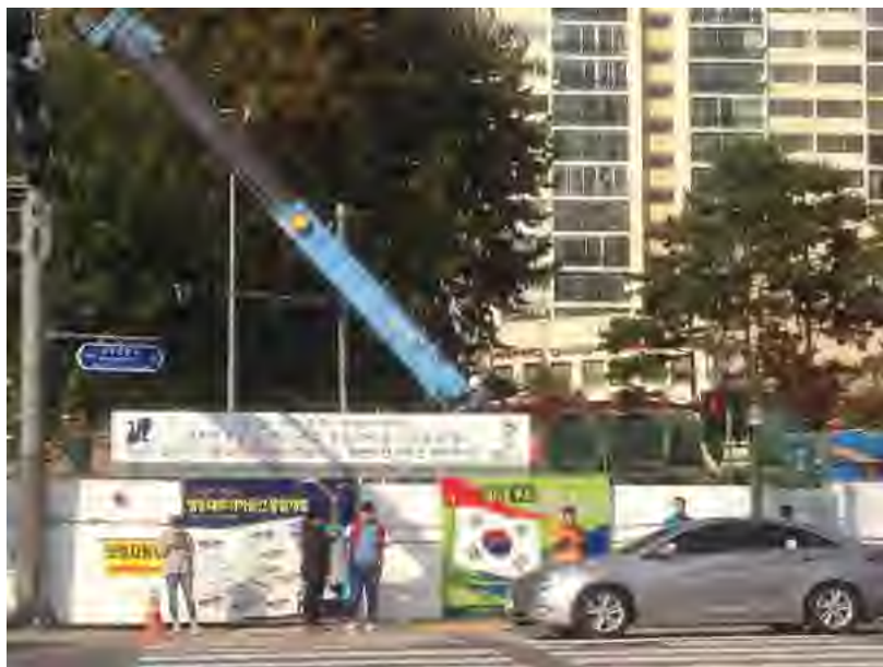
그림 7 대치배수분구 하수관로 공사현장(황진태 촬영 2017.11.4.)
